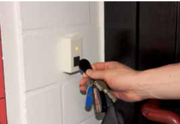
Scharfgeschaltet wird z.B. über ein zusätzliches Schloss in der Tür oder einem Transponder. Ein Transponder ist ein elektronischer Schlüssel. Er wird vor das Lesegeräte gehalten, und die erforderlichen Daten – passt der „Schlüssel“? – werden ohne weiteres Zutun übertragen.
