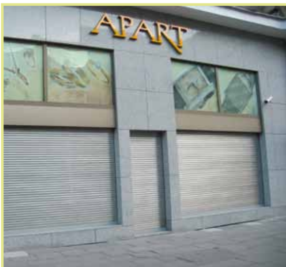
Schaufenster mit einbruchhemmenden Rollläden
