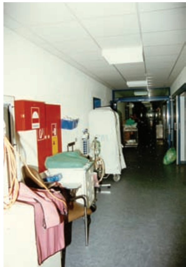
Bild 11a: Stationsflur im 9. OG im Ernstfall nur eingeschränkt nutzbar
