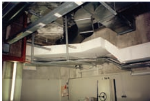
Bild 07: Feuergeschützter Lüftungskanal
