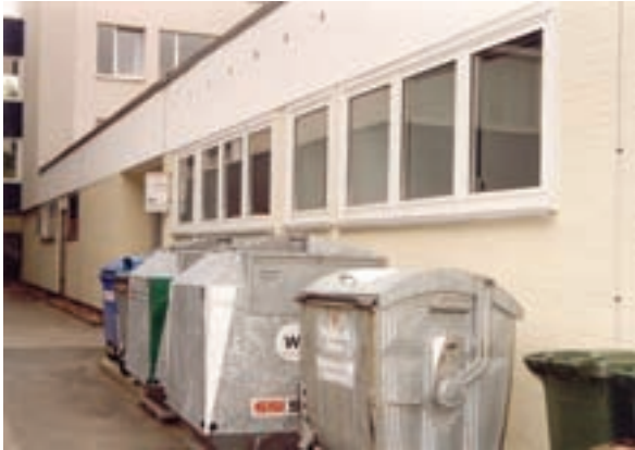
Bild 10: Müllcontainer sollten nicht an der Hauswand aufgestellt werden
