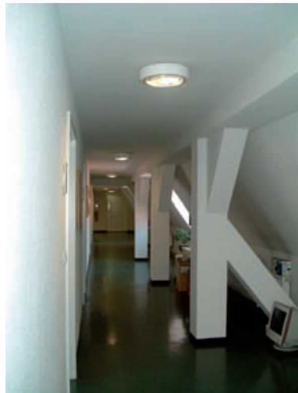
Abbildung 10: Durch Bekleidung ertüchtigte Holz-Tragkonstruktion, erster Rettungsweg (Quelle: A. Brockmeier)
