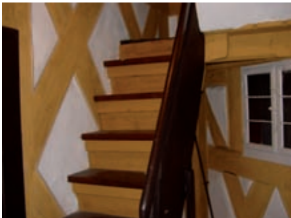
Abbildung 7: Holztreppe (Quelle: J. Zenger)
