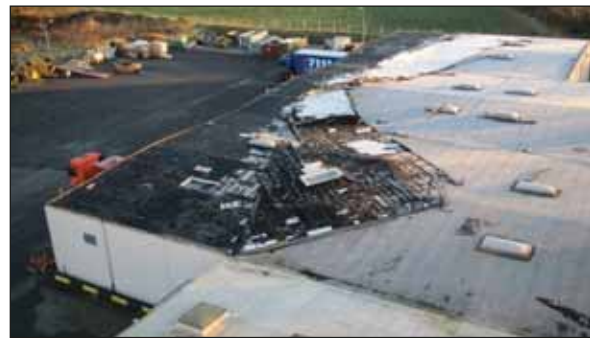
Abb. 14: Abgehobene Dachschichten der Halle 2 (Mitte) und 3 (hinten) mit beschädigten Lichtkuppeln (Quelle: HGI)
