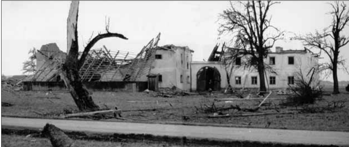
Abb. 2: Ein allein stehendes Gebäude nach einem Sturm
