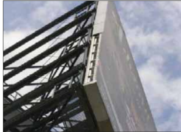
Abb. 22: Abgerissene Seitenabdeckung der Werbetafel (Quelle: R+V)
