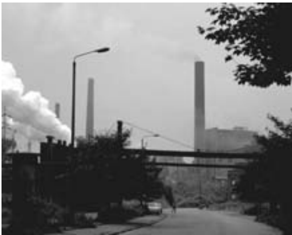
Abbildung 7: Schornsteine ragen in ein stärkeres Windfeld hinein
