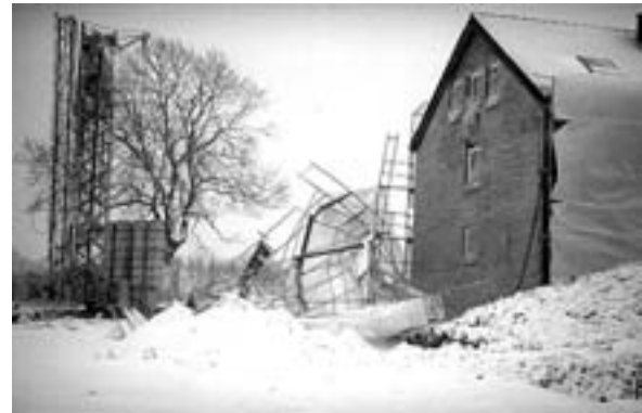
Abbildung 6: Gerüste nach einem Wintersturm
