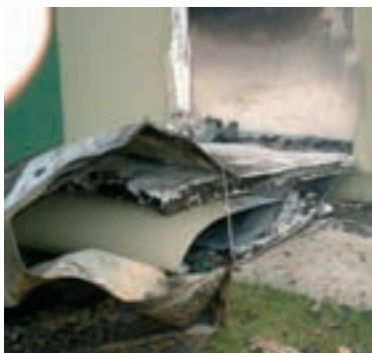
Bild 6.02: Sandwichelemente nach einem Brand
